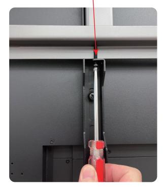
最後に固定用のネジをしっかり締めます。
